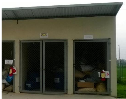
Hình 3.47. Kho lưu giữ chất thải rắn công nghiệp thông thường có diện tích 80 m 2 của Trạm bơm chuyển tiếp nước thải Đồng Điều
