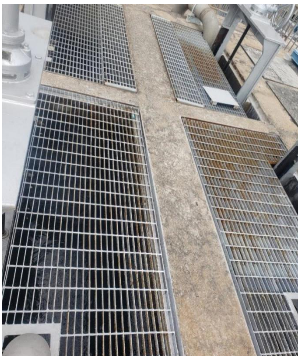
Bể phân phối Giai đoạn II
