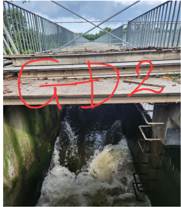
Mương thoát nước Giai đoạn II
