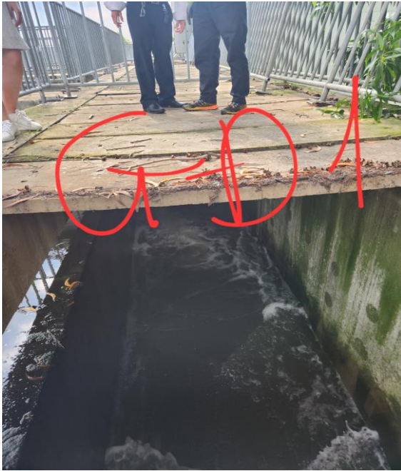
Mương thoát nước Giai đoạn I
