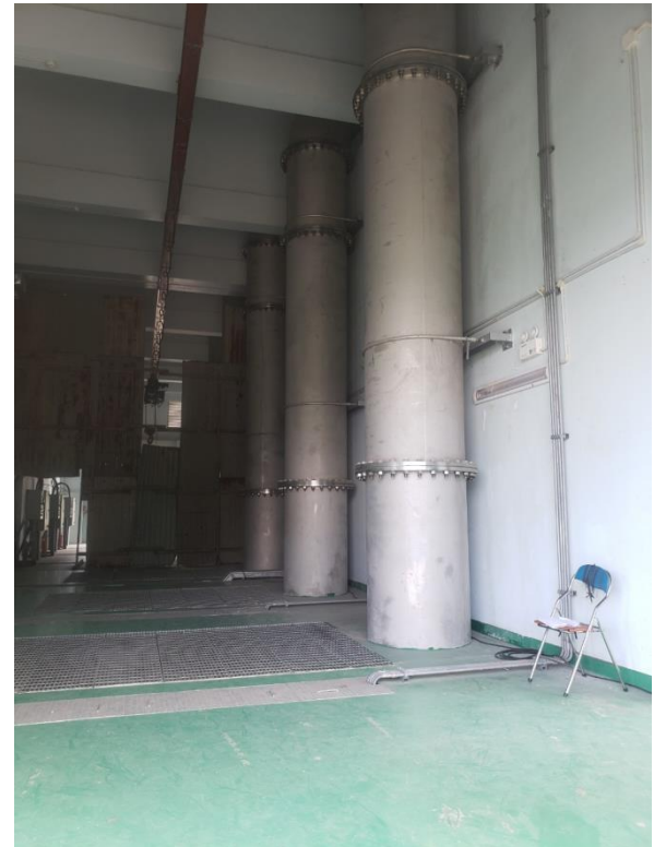
Khu trạm bơm thuộc Giai đoạn II
