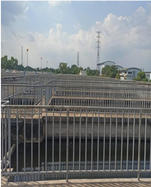
Hình 3.32. Bể lắng thứ cấp giai đoạn I
