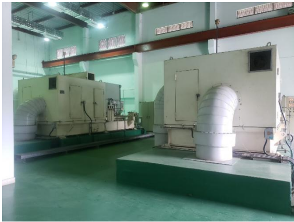
Hình 3.42. Hệ thống thông gió tại khu vực Nhà thổi khí
