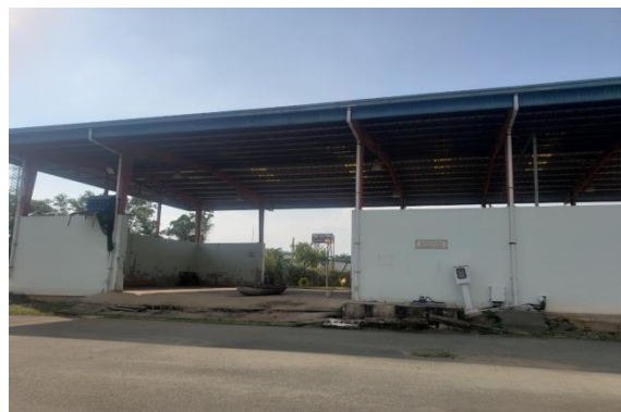
Hình 3.48. Kho lưu giữ chất thải rắn công nghiệp thông thường có diện tích 300 m 2 của Nhà máy XLNT Bình Hưng
