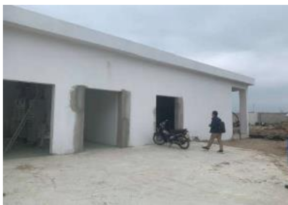
Nhà điều hành Trạm XLNT
