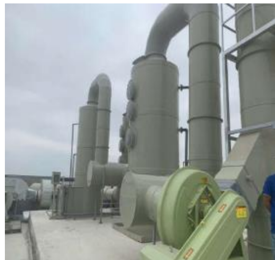
Hình 3. 12. Hình ảnh hệ thống XLKT đã lắp đặt tại mái nhà xưởng C1
