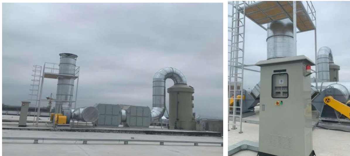
Hình 3. 15. Hình ảnh hệ thống XLKT đã lắp đặt tại mái nhà xưởng C1
