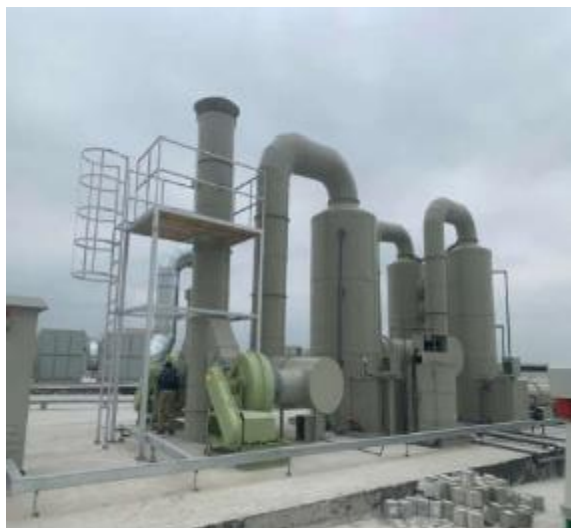
Hình 3. 12. Hình ảnh hệ thống XLKT đã lắp đặt tại mái nhà xưởng C1
