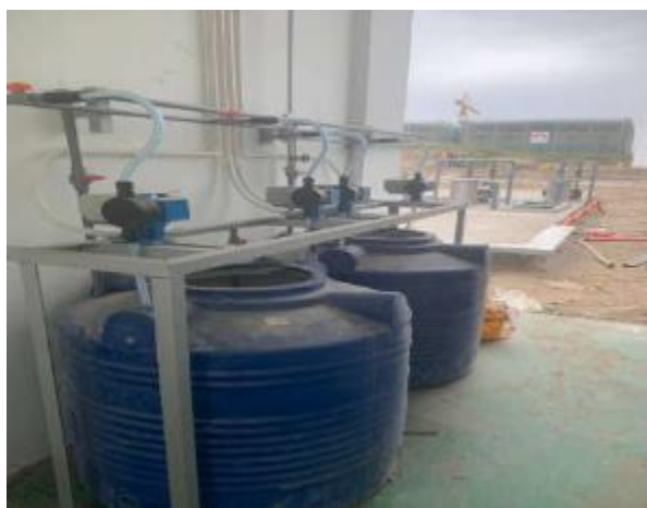
Bồn chứa hóa chất khử trùng
