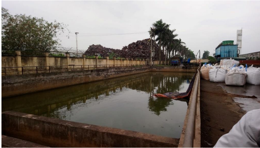
Hình ảnh bể xử lý và chứa nước mưa bãi phế liệu số 1:
