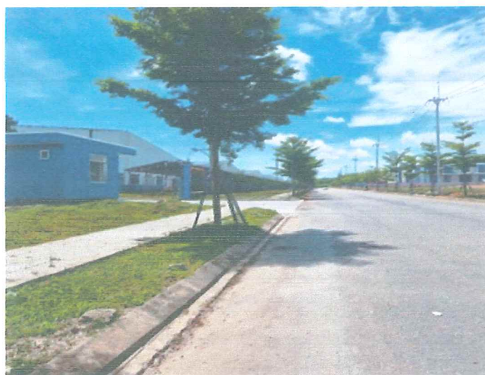
Hình 1. 8. Hình ảnh hệ thống giao thông, cấp điện, cây xanh tại KCN
