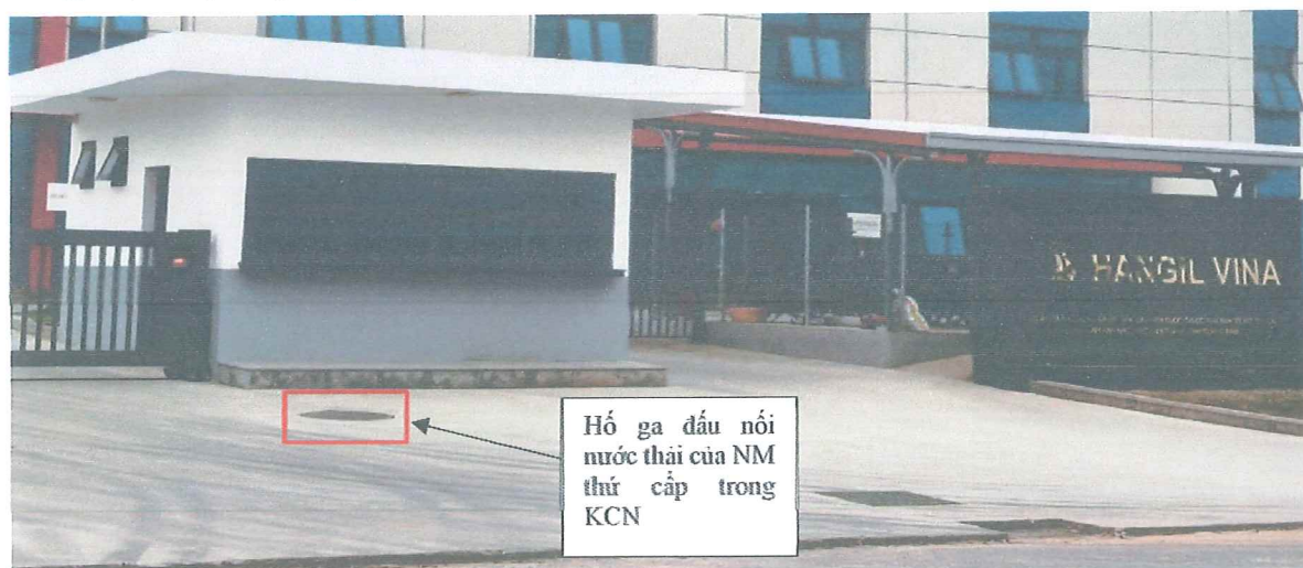
Hình 3. 10. Đại diện hố ga đầu nối nước thải của nhà máy trong KCN
