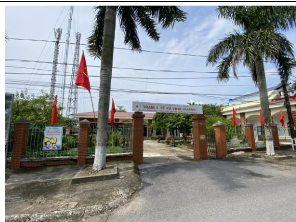
Trạm y tế
