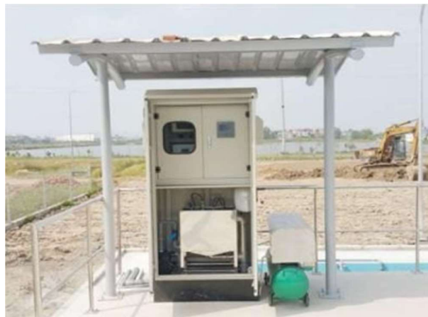
Hình 3.3. Tủ quan trắc nước thải online
