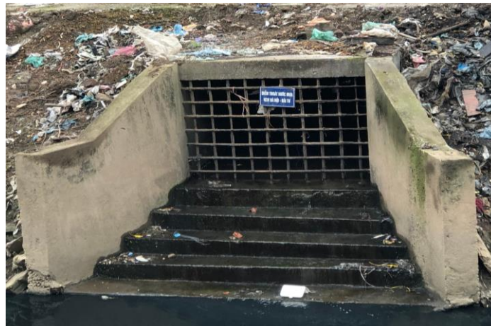
Hình 3.3. Hình ảnh 03 cống xả nước mưa của KCN
