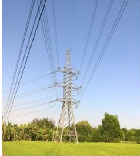
Tuyến đường điện 110kv Phú Lâm – Mỹ Tho
