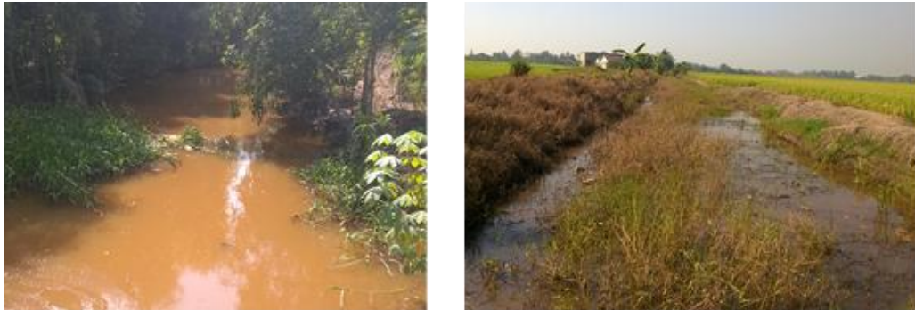
Mương thoát nước trong khu vực
