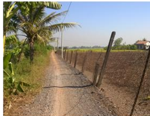
Đường hiện trạng trong khu vực
