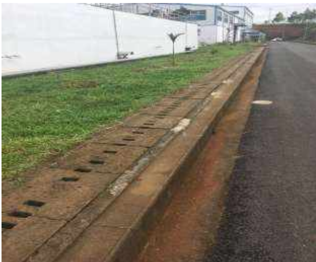
Hình 3.3 Hình ảnh mương thoát nước mưa và hố ga thoát nước mưa tại nhà máy
