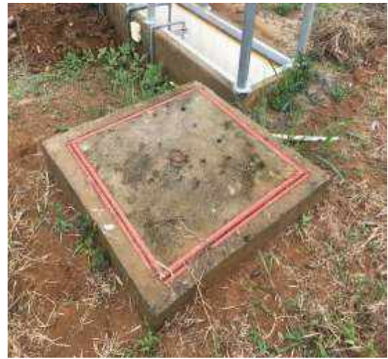
Hình 3.3 Hình ảnh mương thoát nước mưa và hố ga thoát nước mưa tại nhà máy
