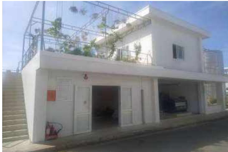
Nhà điều hành hệ thống XLNT
