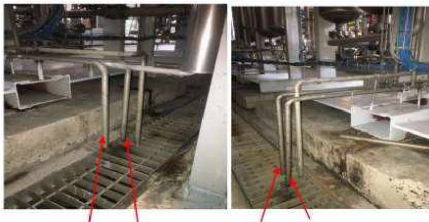
Hình 3.23 Vị trí ống xả khí CO 2 số 03, 04 trong hệ thống thu hồi CO 2
