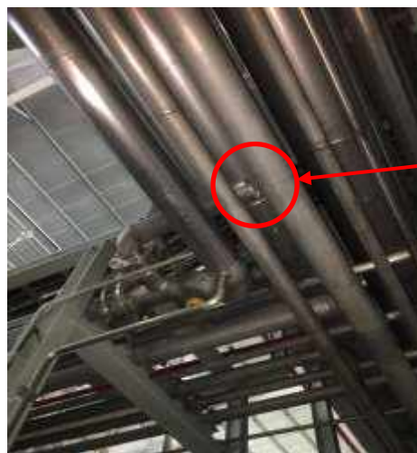
Hình 3.21 Vị trí ống xả khí CO 2 số 01 trong hệ thống thu hồi CO 2
