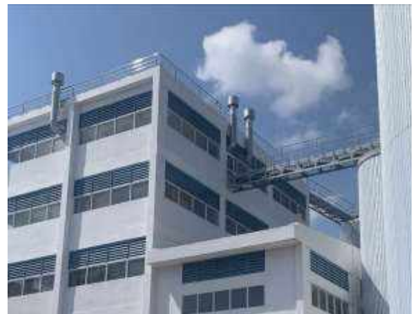
03 ống thoát bụi thải của hệ thống xử lý bụi từ quá trình xử lý nguyên liệu malt và gạo
