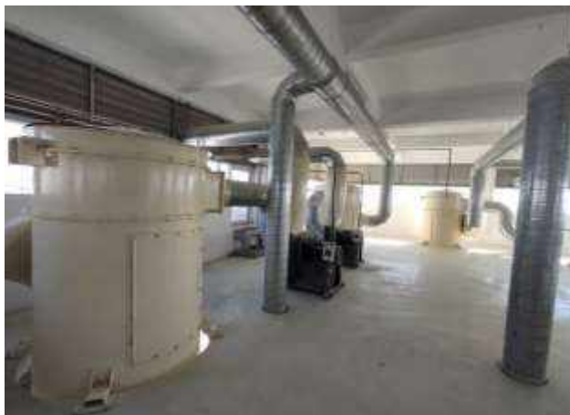
Hệ thống xử lý bụi từ quá trình xử lý malt gạo
