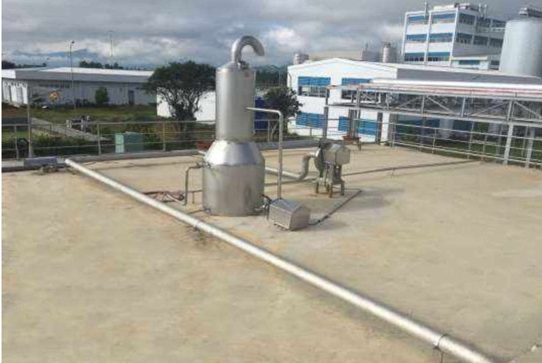
Hình 3.25 Hình ảnh tháp hấp thụ khí thải tại HTXLNT
