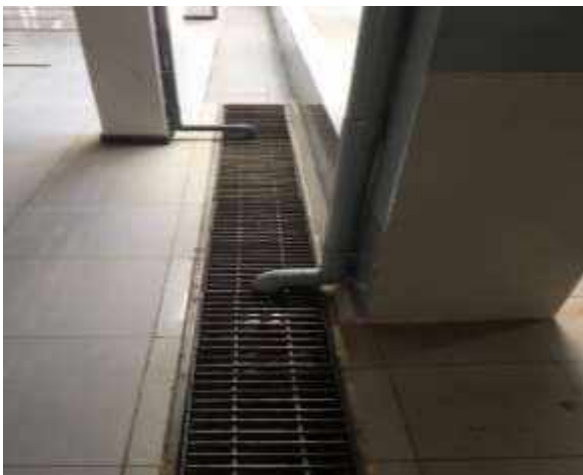
Mương thoát nước thải
