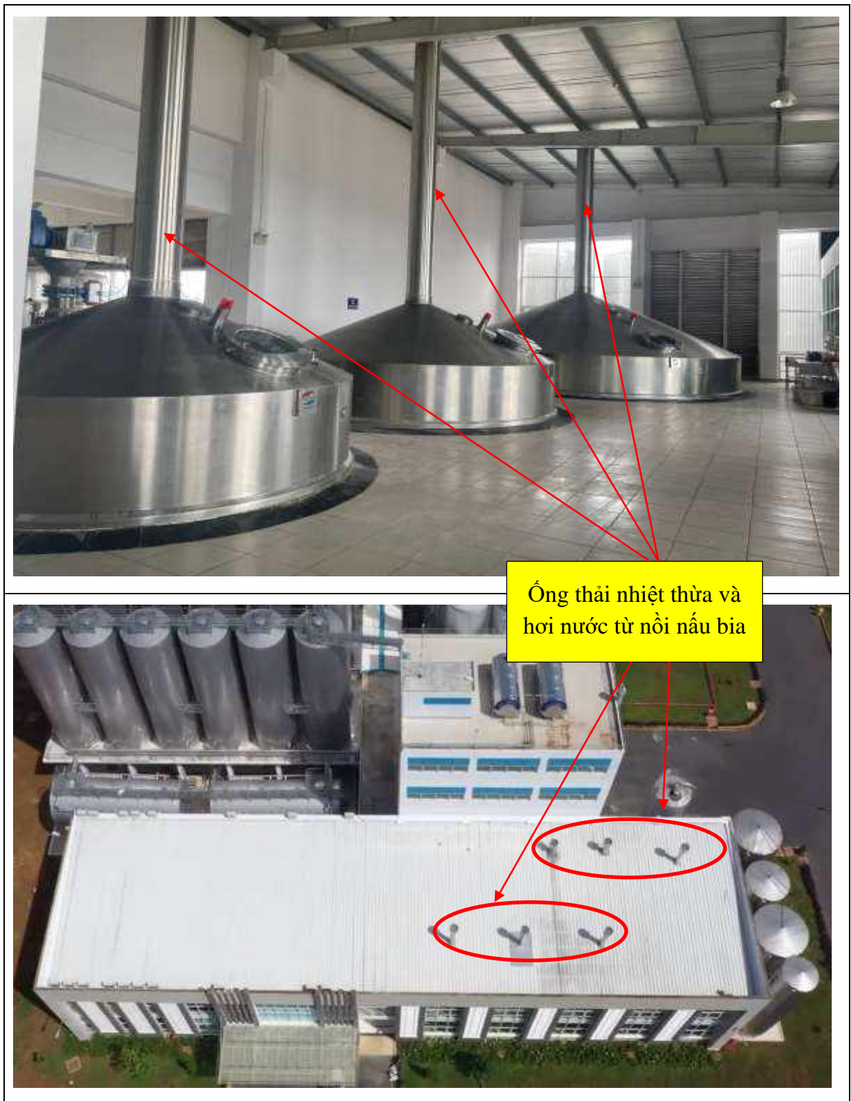
Hình 3.24 Hình ảnh ống thải và vị trí phát tán hơi nước và nhiệt thừa từ nồi nấu bia
