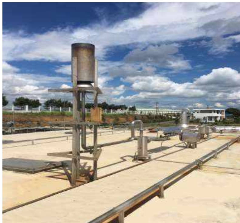
Hình 3.26 Hình ảnh đuốc đốt khí metan
