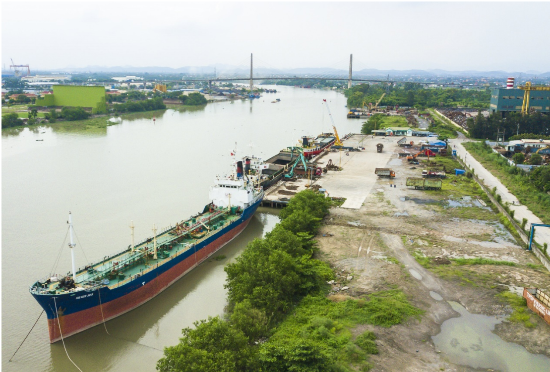
Hình 1.6. Khu vực cầu cảng
