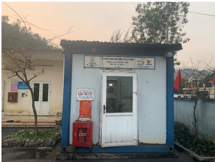
Hình 1. 11. Nhà đặt trạm quan trắc
