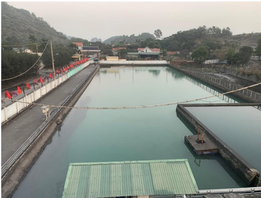
Hình 1. 3. Bể lắng trạm XLNT
