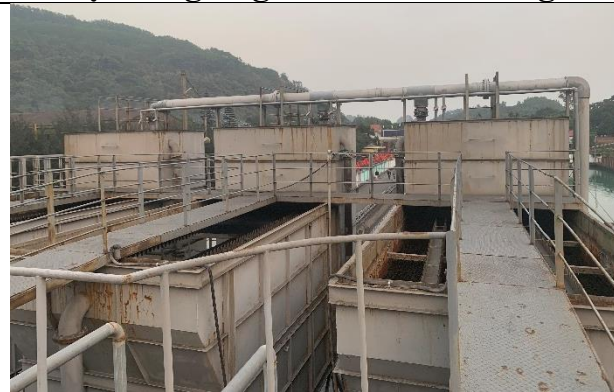
Máng thu nước răng cưa và tấm lắng lamella
