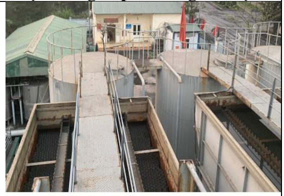
Máng thu nước răng cưa và tấm lắng lamella
