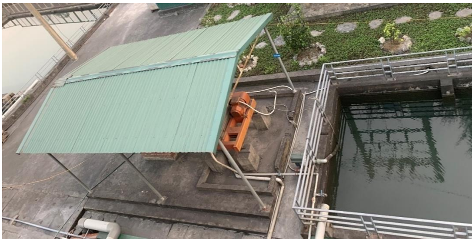
Hình 1. 8. Hình ảnh nhà che máy ép bùn
