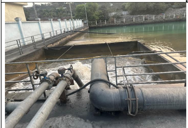
Máy thổi khí và hệ thống phân phối khí tại ngăn tiếp nhận trong bể lắng
