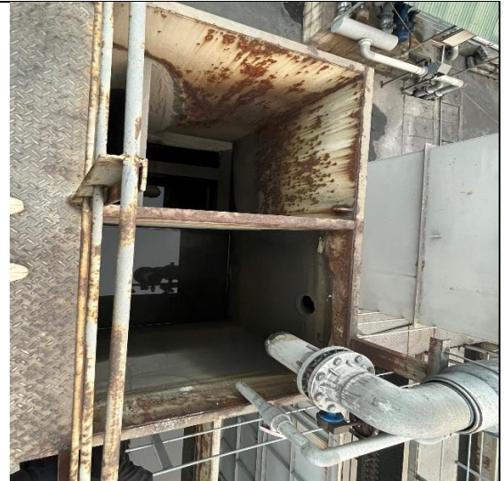
Hệ thống ống bơm nước vào ngăn hòa trộn và ngăn phản ứng keo tụ
