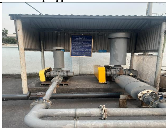
Máy thổi khí và hệ thống phân phối khí tại ngăn tiếp nhận trong bể lắng
