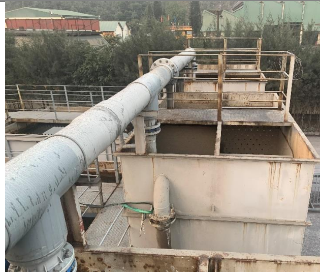
Hệ thống ống bơm nước vào ngăn hòa trộn và ngăn phản ứng keo tụ
