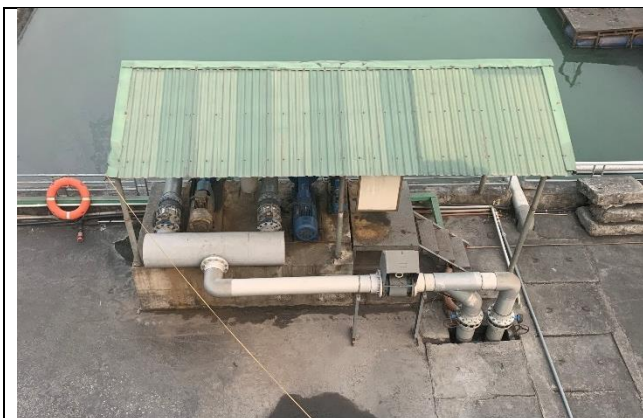
02 Bơm nước thải lên cụm thiết bị hợp khối
