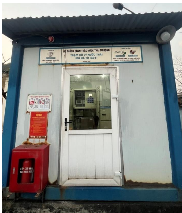
Hình 3. 14. Nhà đặt thiết bị quan trắc tự động nước thải của trạm xử lý nước thải Hà Tu
