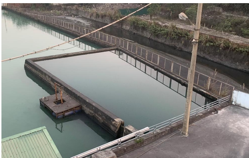
Hình 1. 7. Hình ảnh bể chứa bùn số 2
