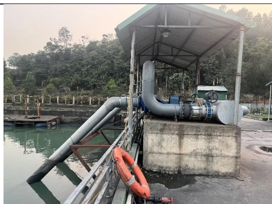
02 Bơm nước thải lên cụm thiết bị hợp khối
