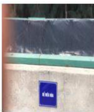
Bể điều hòa
